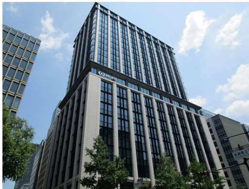
大阪ビル外観
