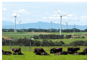
蓄電池併設の大規模商用風力発電施設への融資
