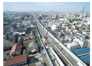
修繕工事中の高速道路
