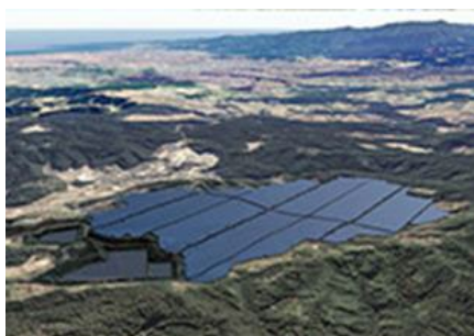
パシフィック・エナジー細江メガソーラー発電所
